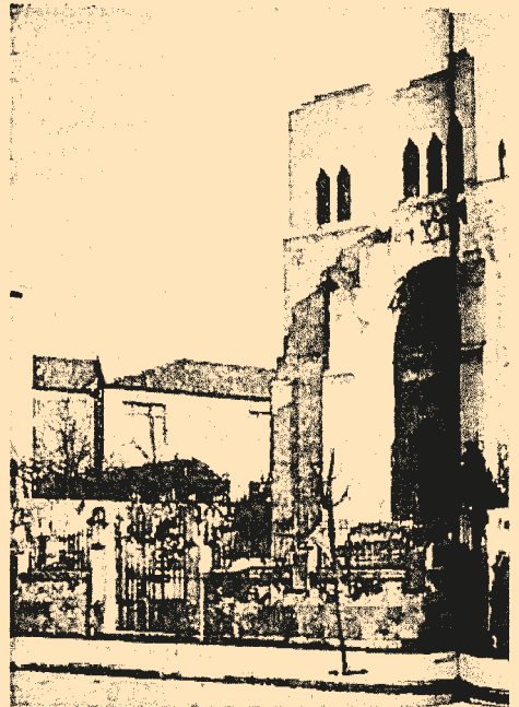
VISTA GERAL DO EXTERIOR DA CATHAL JU- INAUGURADA SOLENEMENTE A 16 DE JUNHO 1
